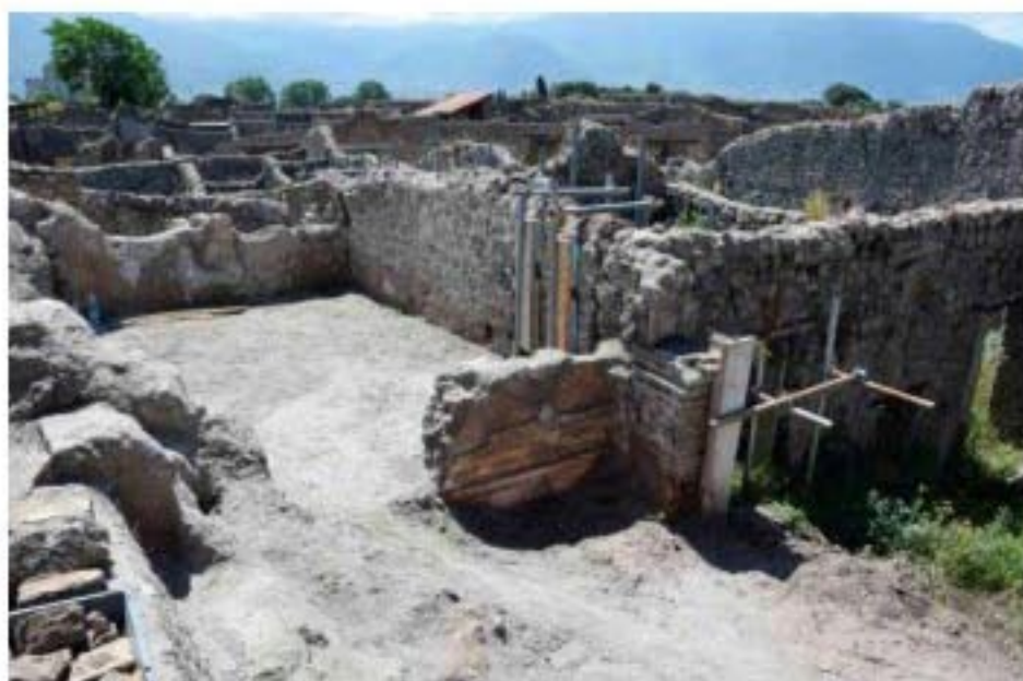
Una fase della messa in sicurezza del fronte di scavo. L'area verrà restaurata e inserita in un nuovo percorso
