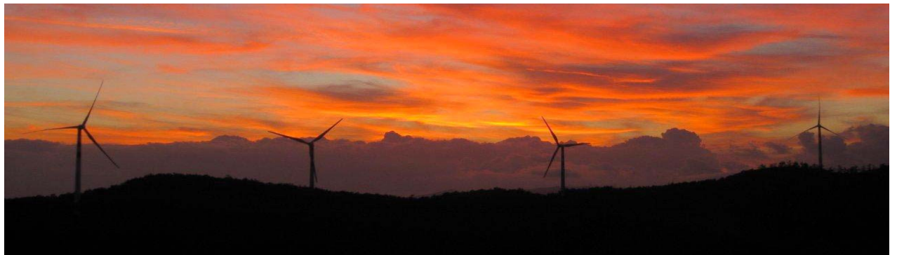
Parco eolico di Montecatini Val di Cecina (LEITWIND)
