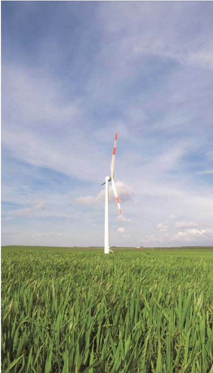
Parco eolico Torremaggiore (LEITWIND)
