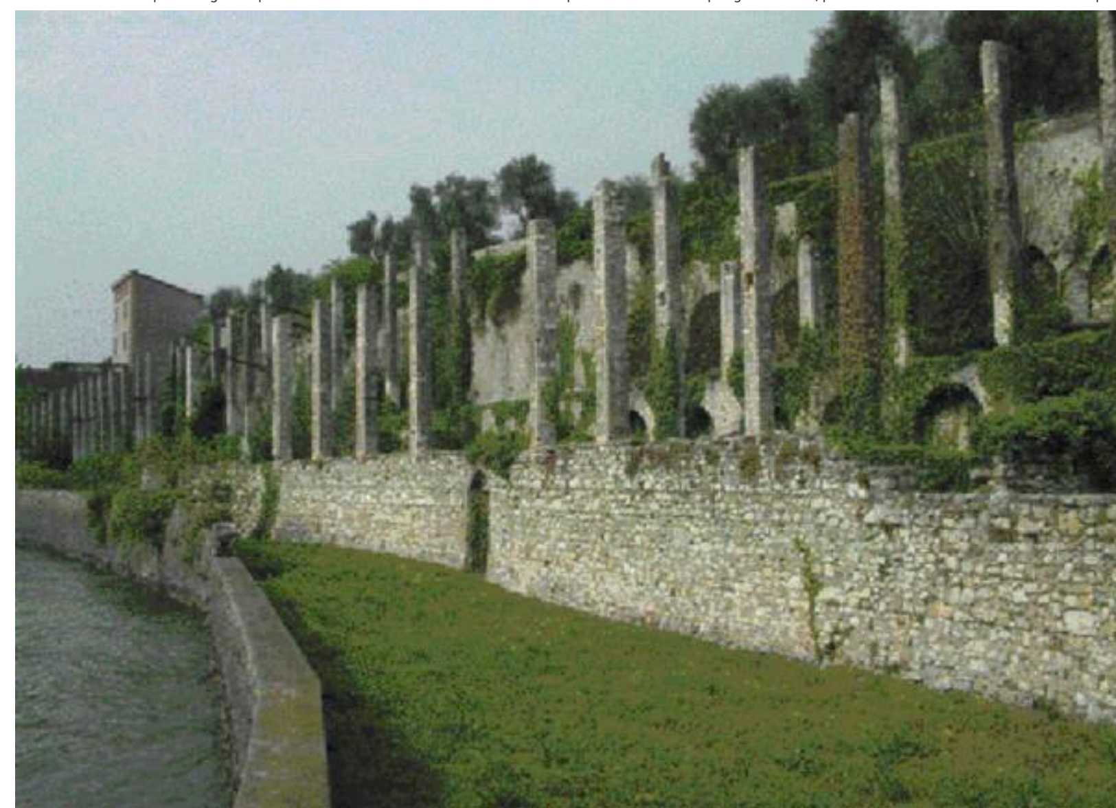
Si sono in parte integrate le porzioni crollate o assenti con nuovi serramenti che riprendono la scansione tipologica dei caselli, piuttosto che con una muratura in sasso sottosquadro
