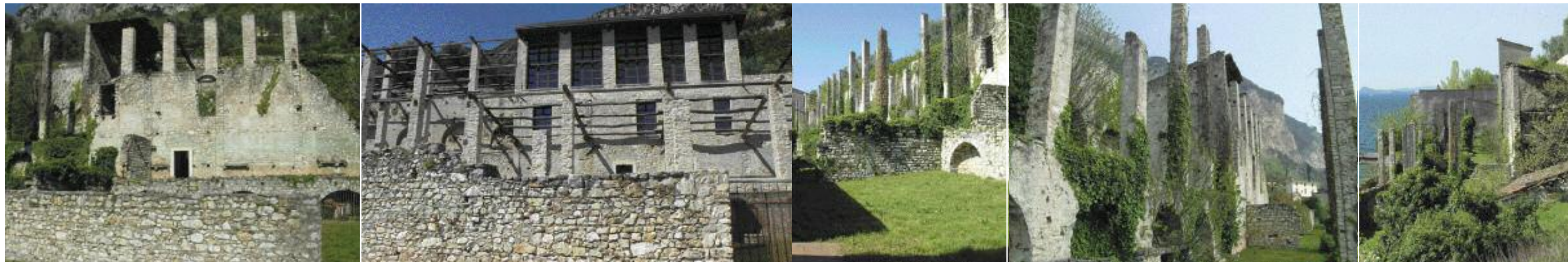
Si sono in parte integrate le porzioni crollate o assenti con nuovi serramenti che riprendono la scansione tipologica dei caselli, piuttosto che con una muratura in sasso sottosquadro
