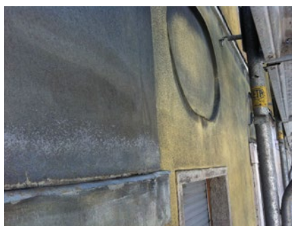
Pulitura tramite apparecchiature Ibiz su intonaco strollato (la rimozione della pellicola di colore giallo ha permesso di recuperare il sottostante intonaco grigio strollato), su cornicioni in cemento, su lastre in Travertino (rimozione di scritte vandaliche e contestuale mantenimento della patina)
