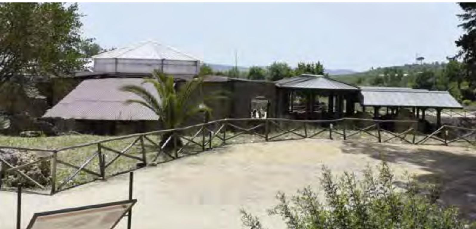
Non avevo ancora visto la faraonica opera con la quale si è sostituito l'intervento di Minissi realizzato negli anni '70 del secolo scorso. La nuova architettura dallo scheletro in tubolari di ferro ha una struttura di copertura in legno lamellare, manto in lamiera di rame e rivestimenti verticali in pannelli di estruso plastico rifiniti con retina e intonachino di resina.
